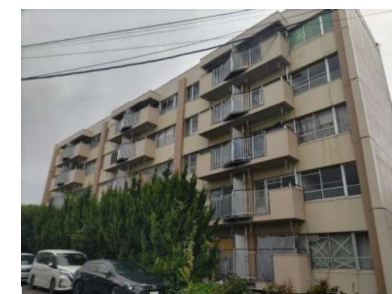
市営長府八幡住宅
