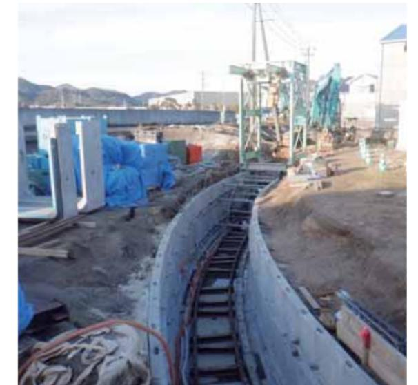
浸水対策のための雨水渠布設工事
