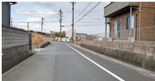
外側線を復旧した通学路
