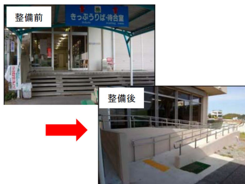
▼駅舎のバリアフリー化・エレベーターの設置
