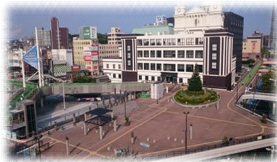
下関駅前人工地盤全景
