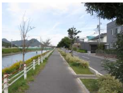
新下関西地区 (綾羅木川沿道)
