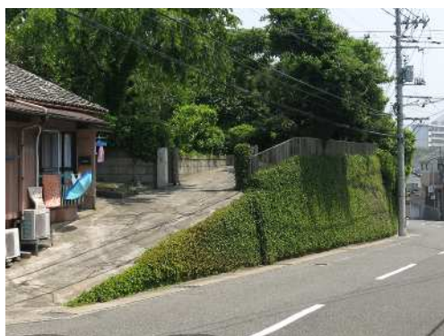
擁壁の緑化（大坪本町付近）
