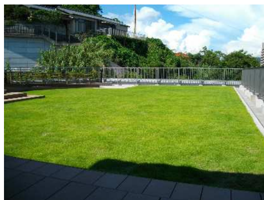
屋上緑化（やまぎん史料館）
