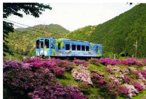
線路沿いの法面緑化の例
