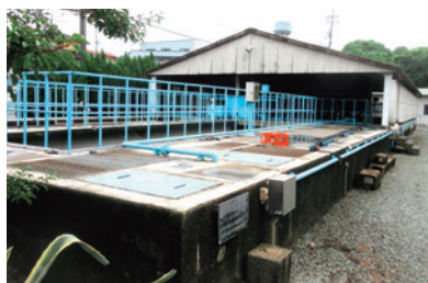
豊万台団地汚水処理施設
