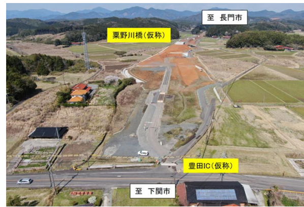
令和8年3月時点整備状況 出典: 山陰道ポータルサイト
