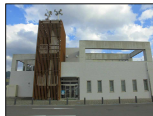
菊川保健センター (菊川総合支所内)
