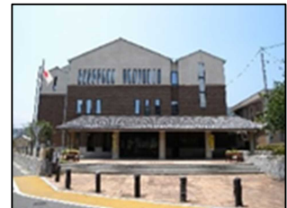
山陽保健センター (長府東公民館内)
