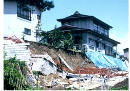
擁壁の倒壊による宅地被害の事例
