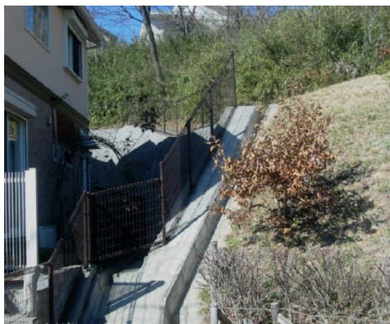
擁壁の設置によるがけの補強例
