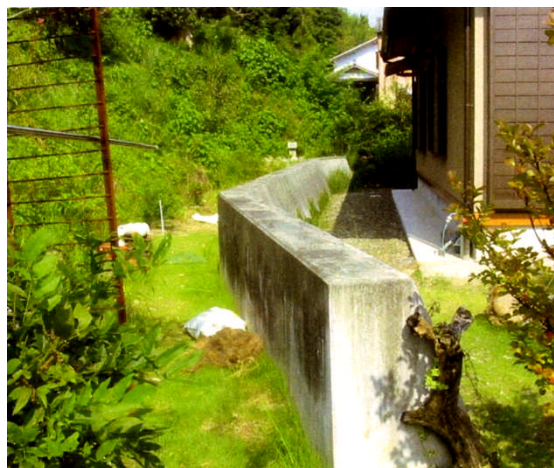
待ち受け擁壁の設置例
