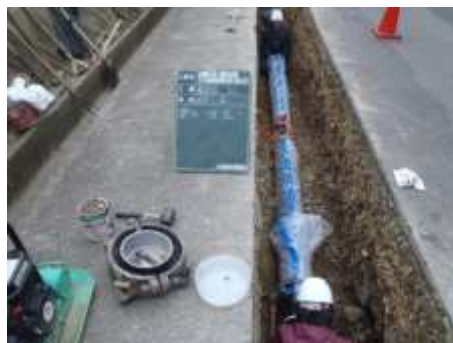
配水管布設替えの様子
