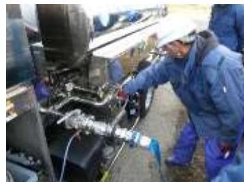
応急給水の様子
