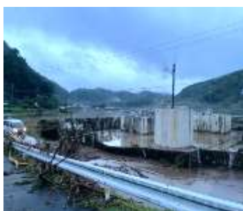
豊北町小河内水源地 濁水流入
