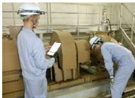
水道 設備台帳端末を使用した点検
