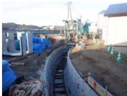
雨水渠の整備
