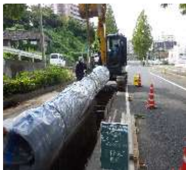
老朽管更新工事（水道）
