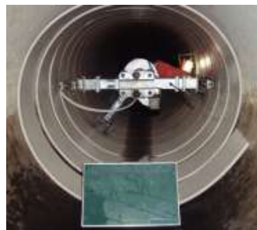
老朽管更生工事（下水道）
