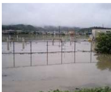
菊川浄水場 冠水
