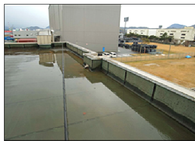
屋上コーキング
