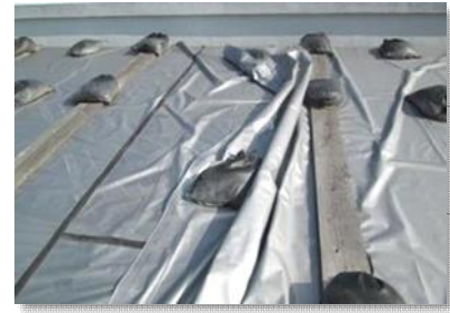
体育館屋根防水 応急処置
