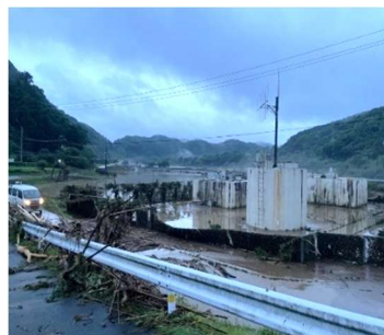
豊北町小河内水源地 濁水流入
