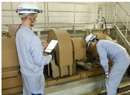
水道 設備台帳端末を使用した点検
