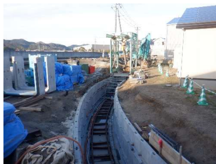
雨水渠の整備
