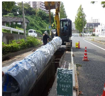
老朽管更新工事
