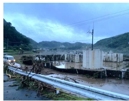
■豊北町小河内水源地濁水流入
