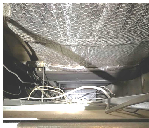
天井内ダクトの様子 (※照明器具撤去後撮影)
