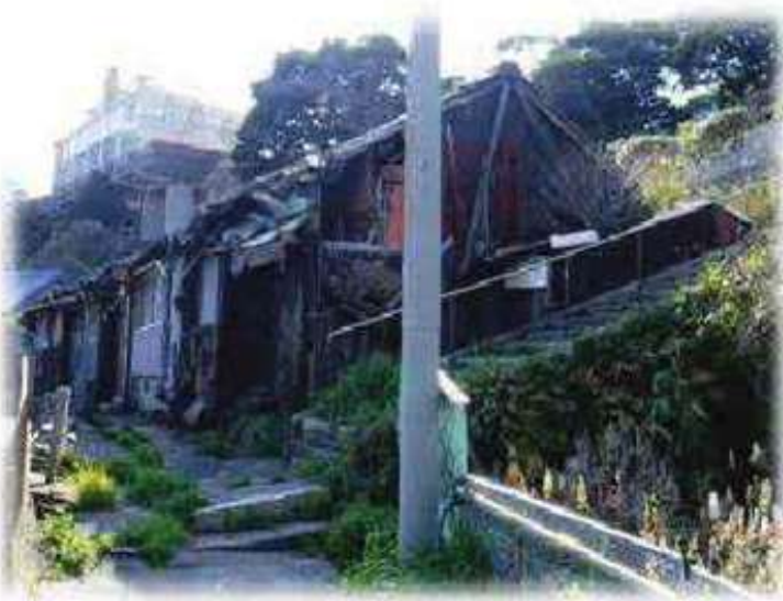
危険な空き家
