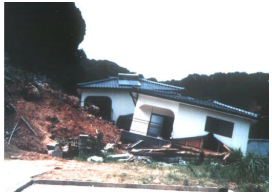
裏山のがけ崩れによる宅地被害
