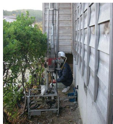
地盤調査の例
