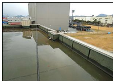
屋上コーキング
