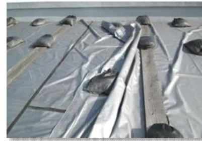
体育館屋根防水 応急処置
