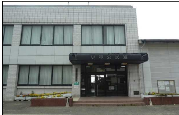
No.4 豊浦総合支所小串支所
