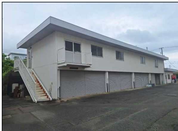
No.2 豊浦総合支所車庫
