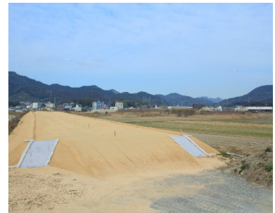
▲下小月バイパス(建設中)
