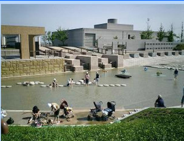
〔乃木浜総合公園親水広場〕 処理した水を再利用しています。
